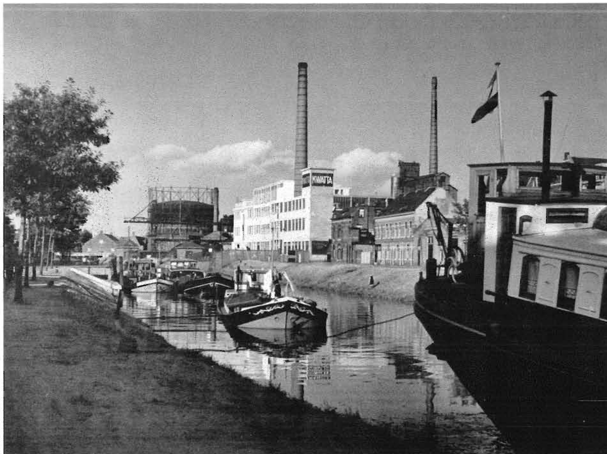
9. Gezicht op de Nijverheidssingel uit 1952 met de Kwattagebouwen in betonarchitectuur. Daarachter de Gasfabriek, waar de aanvoer van steenkolen per schip plaatsvond. De bovenbouw van de oveninstallatie is naast de rechter schoorsteen zichtbaar.
