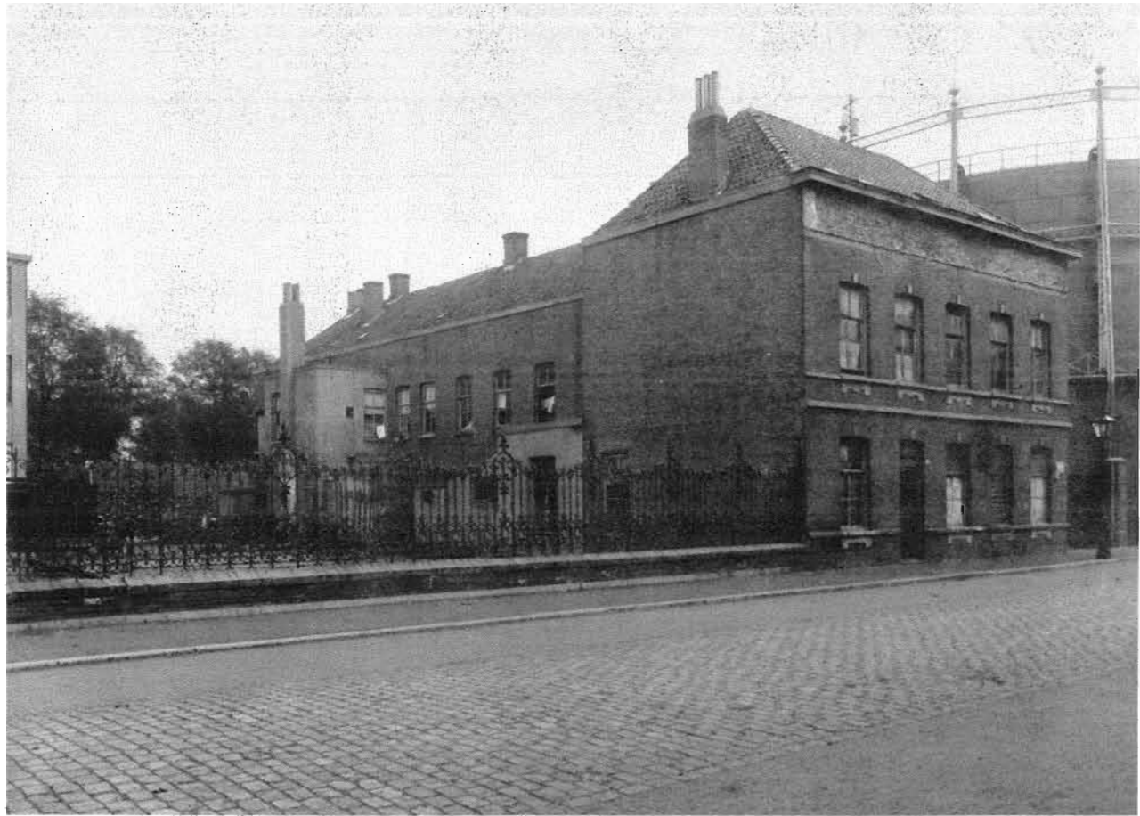
13. Gezicht vanuit de Middellaan op de achterzijde van de sigarenfabriek A. J. Meeuwesen. Vlak voor de sloop, ten behoeve van de nieuwbouw van de gasfabriek, in 1921 genomen. Rechts op de foto de gashouder aan de Middellaan.
