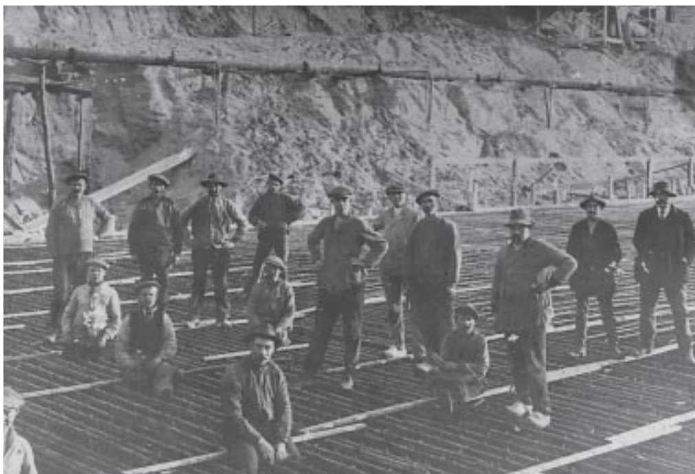
8. Het werken aan de sluizen bij het Wilhelminakanaal rond 1910.
