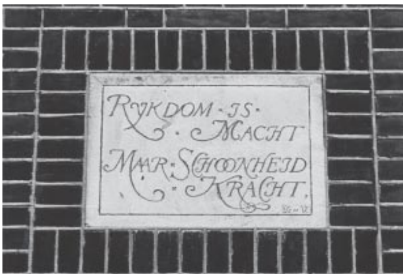
2. Gevelsteen van het pand Academiesingel 20.
