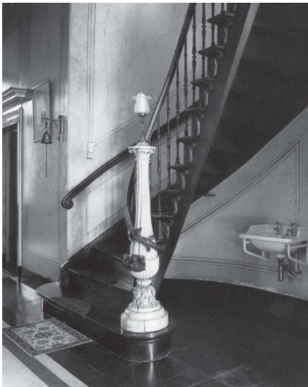
6. De rijk gedecoreerde trappaal van het half-ovale trappenhuis waarachter de huiskapel zich bevindt.
