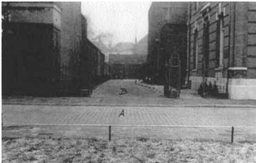
9. Ingang Ortskommandantur, gebouw rechts, gezien vanaf de Willemstraat.
