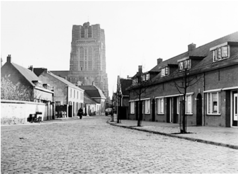
6. Een complex van acht woningen in de Torenstraat, gebouwd in opdracht van J. de Wijs in 1939.
