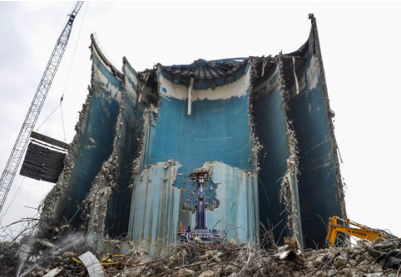
1. Sloop van de suikersilo's aan de Markkade in het jaar 2010 (Bron foto: Stadsarchief Breda)
