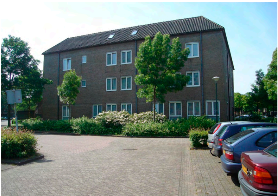
39. Gebouw H, 't Kruidmagazijn, uit 1983, gesloopt in 2019. (Defensie)
