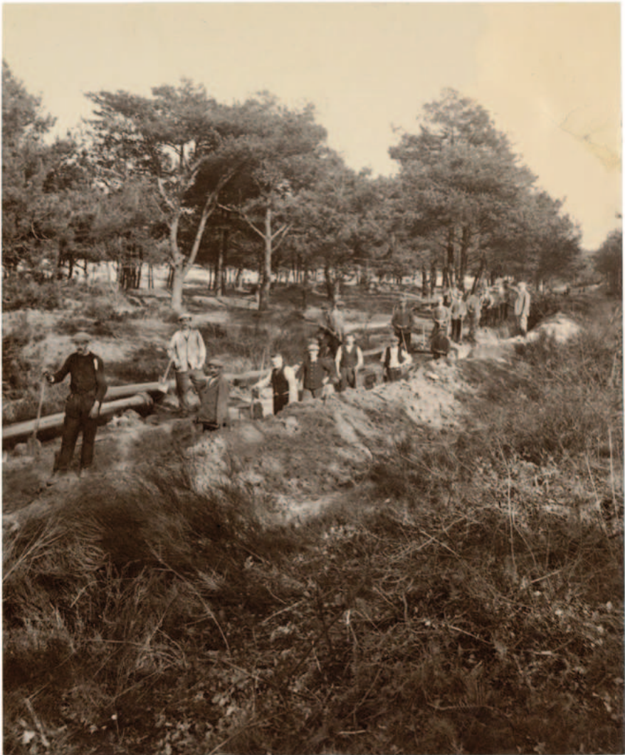
13. Aanleg in 1893 van de eerste watertransportleiding van het pompstation in Dorst naar de watertoren in het Wilhelminapark. (SAB, firma Schreurs, 19880575)
